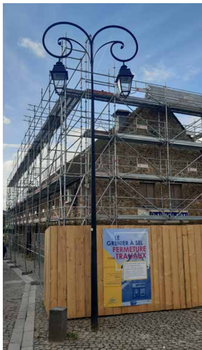
Nouvelle phase de travaux pour le cinéma le Grenier à sel
